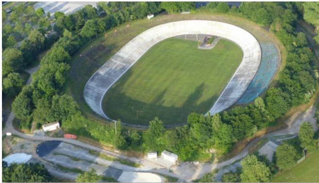
Bei der Einweihung 1953 galt die Radrennbahn als die modernste und schnellste Bahn in Europa. Seit 2012 steht sie unter Denkmalschutz. Die Fahrbahn besteht aus fugenlosem Spannbeton und hat eine Länge von 333,33 Metern. Der Bildungsort Radrennbahn Bielefeld bietet mehrere Möglichkeiten, das Baudenkmal kennenzulernen.
